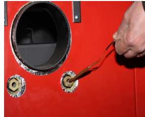
Overkogstermostat føler og kedelføler monteres.
