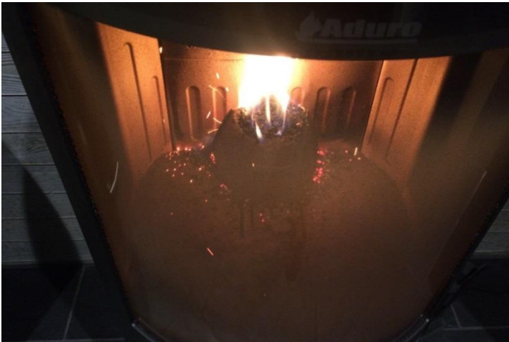
Kleine Flammen und überfüllte Pelletverbrennungsstelle = zu geringer Schornsteinzug
